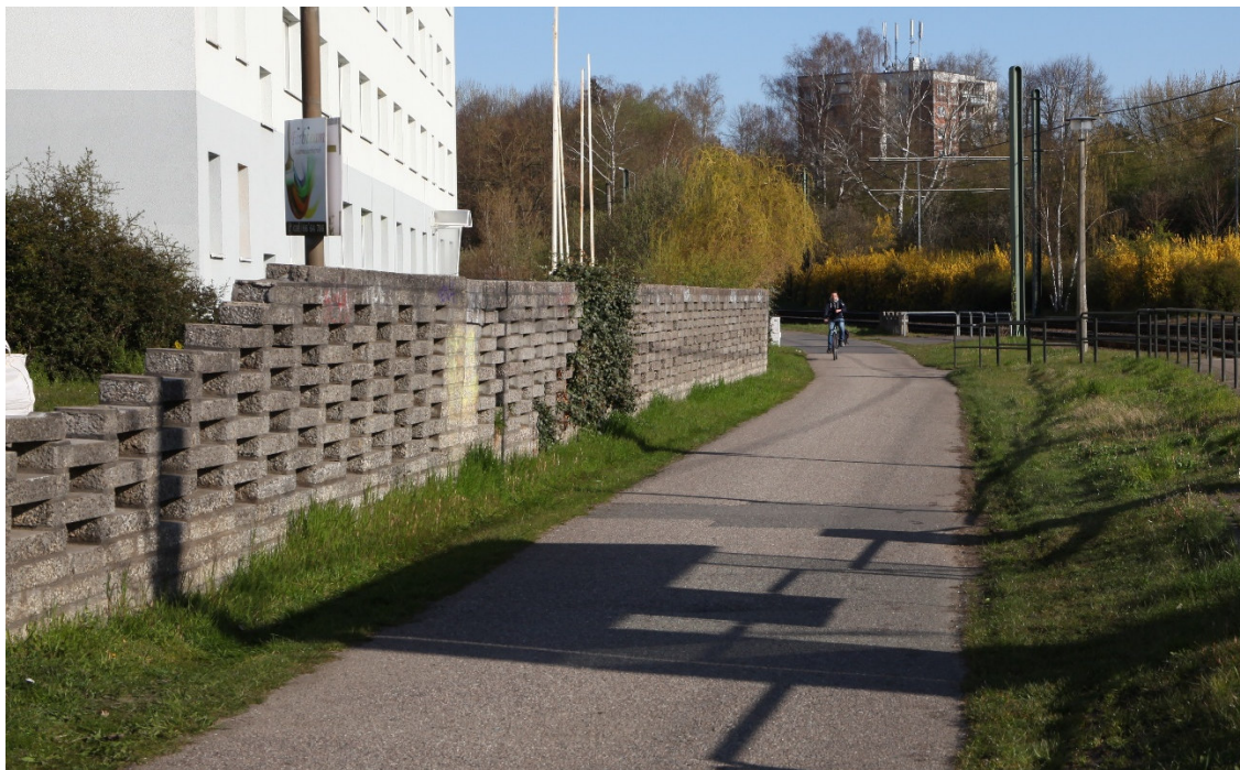
Abbildung 5: Abzubrechende Mauer im Verlauf der Trasse des neuen RSW
